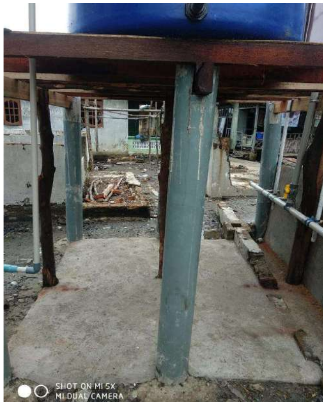
Gambar 4.5 Pembuatan Penyangga Tangki Air
