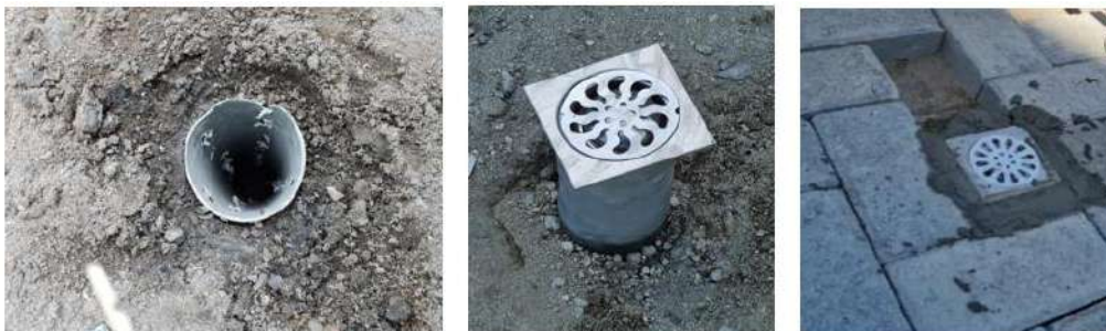
Gambar 4.5 Pembuatan biopori
