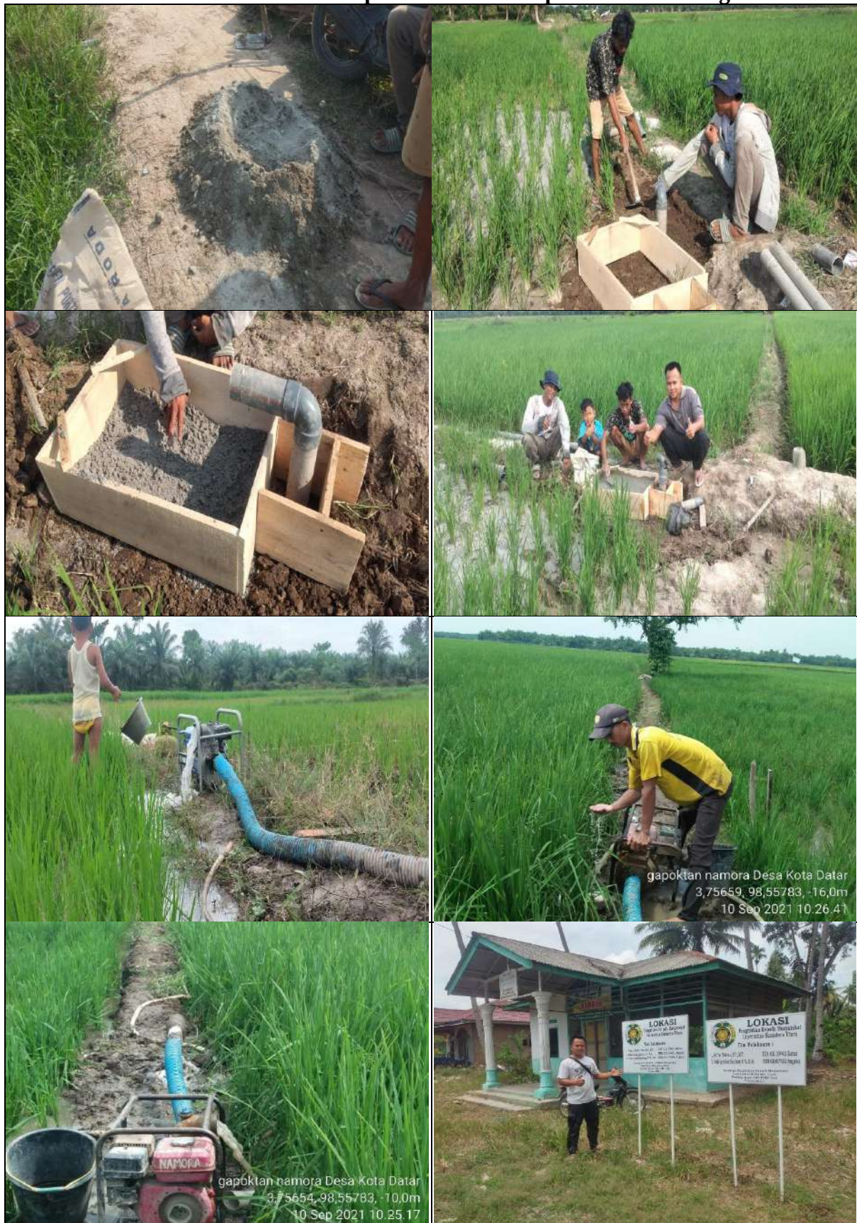
Gambar 2. Sumur Pertama yang Dibangun di Lahan Gapoktan Namora Desa Kota Datar Kecamatan Hamparan Perak Kabupaten Deli Serdang
