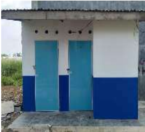
Gambar 3.2 Kondisi kamar mandi Sekolah Swasta Pembangunan Setelah Renovasi
