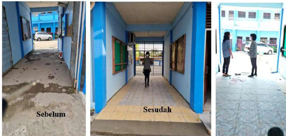
Gambar 4.6 Renovasi lantai, pengecoran dan pemasangan keramik
