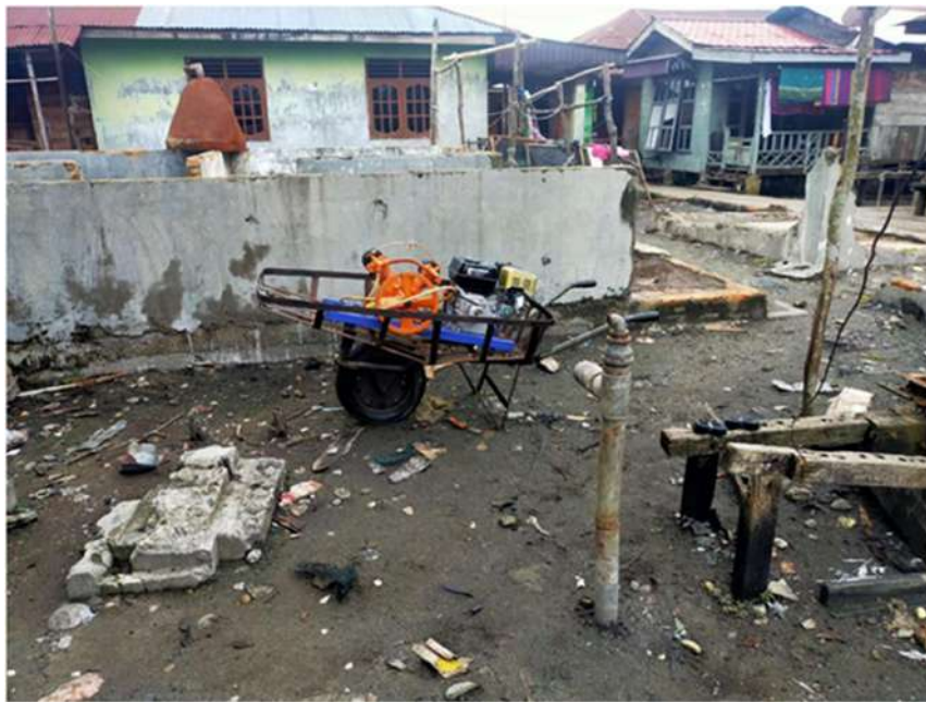
Gambar 4.1 Lokasi Pembuatan Sumur Bor
