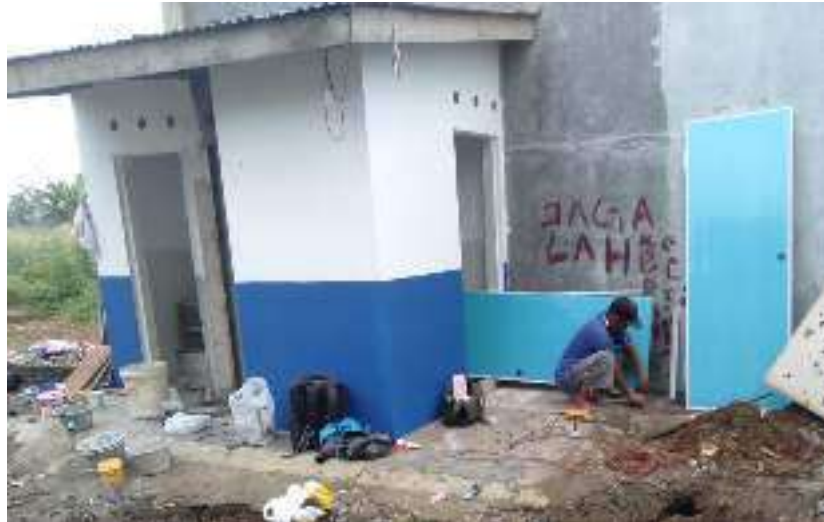
Gambar 1. Proses pengerjaan renovasi kamar mandi oleh tukang (Tanggal 9 – 13 Juli 2021)
