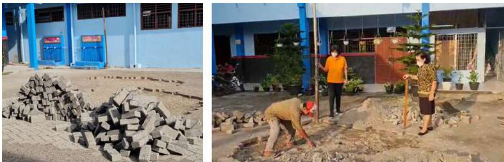
Gambar 4.4 Pembongkaran paving blok
