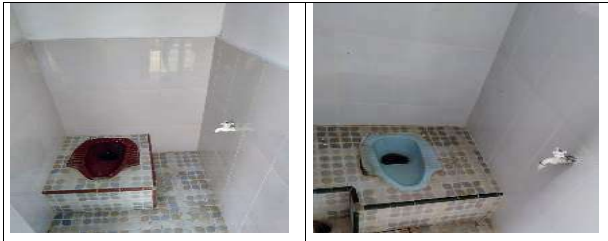
Gambar 4.2. Kondisi kamar mandi setelah pemasangan keramik di dinding
