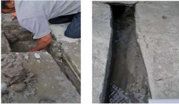
Gambar 4.3 Kegiatan renovasi saluran air dan pembersihan
