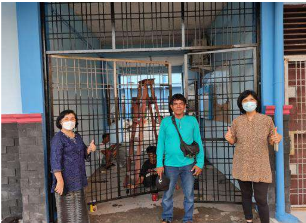
Pintu sudah terpasang dan dilakukan penyetelan pintu pengecatan. Hasil akhirnya dapat dilihat pada gambar di bawah ini, lantai yang indah dan bebas banjir kini.
