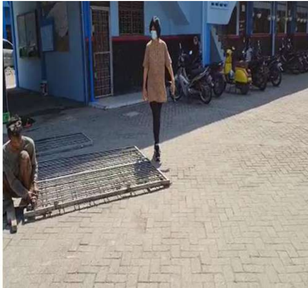
Penyetelan pintu besi, penyesuaian ketinggian lantai yang direhab.
