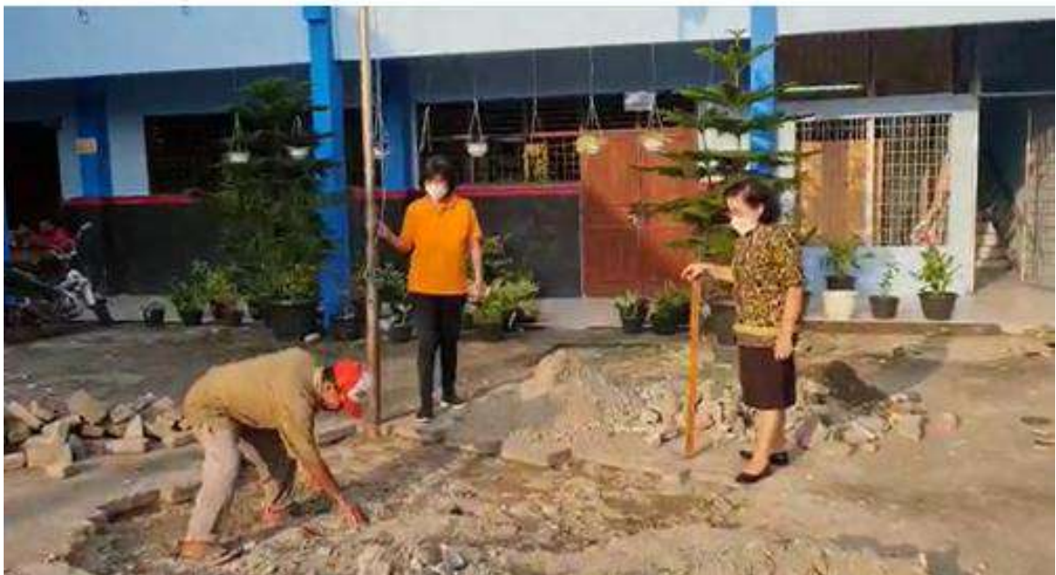
Perbaikan paving blok
