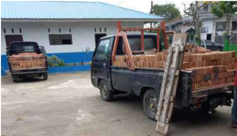
Gambar 4.11. Batu bata yang diberikan ke SD Swasta Pembangunan sebanyak 3100 buah dan semen sebanyak 20 sak
