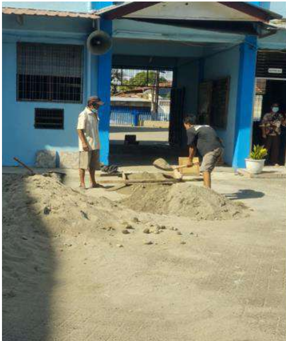
Setelah pengecoran, dilanjutkan dengan pemasangan keramik Dicor dan diberi keramik sehingga tidak lagi banjir.
