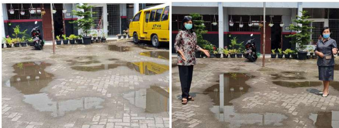
Gambar 1.1. Kondisi sekolah dengan genangan air di lokasi halaman sekolah
