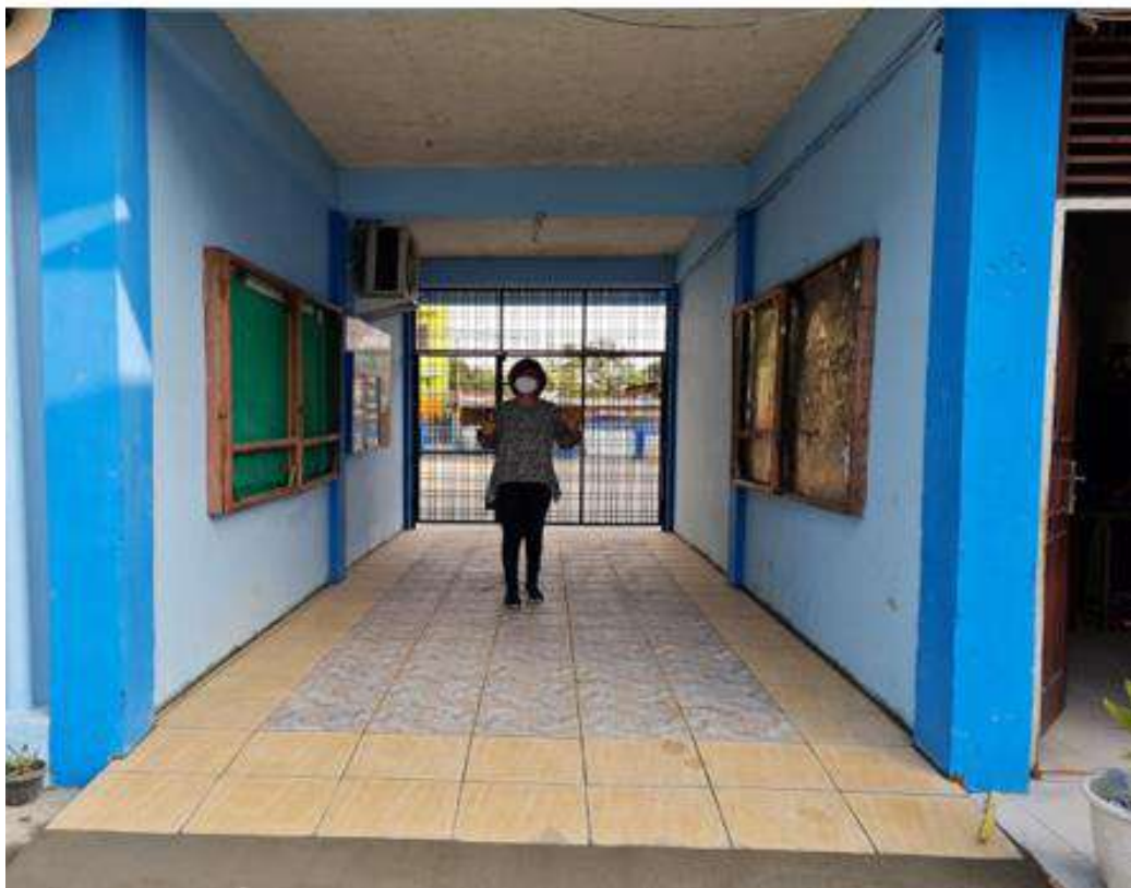
Renovasi akses masuknya air dengan pengecoran dan pemasangan keramik
