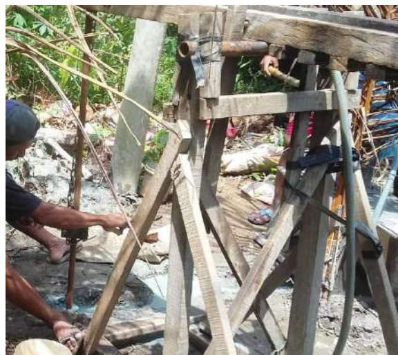
Gambar 4.3 Pembuatan Sumur Bor
